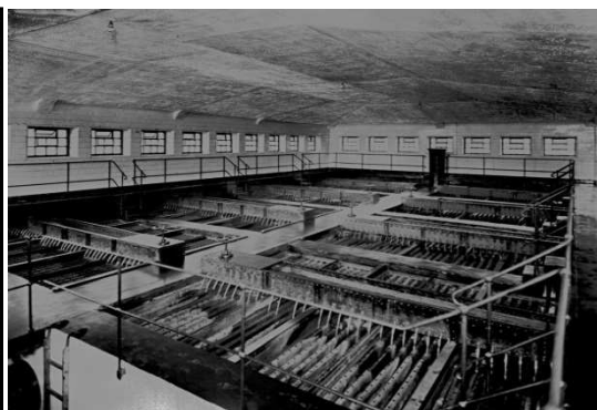
Obr. 2. Rozstřík vody na odželezovně
